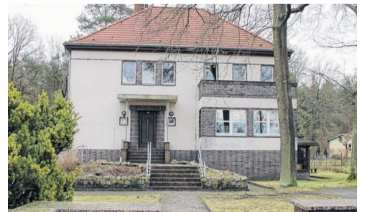
Das ehemalige Jugendhaus „Villa“ in der Prenzlauer Allee wird in den kommenden Monaten komplett umgebaut. FOTO: TONI BECKER
