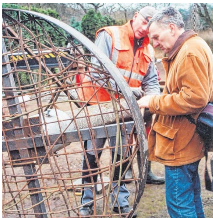
Norbert Bukowski (rechts) vom NABU montiert das eigentliche Storchennest an den Rumpf des Nistplatzes. FOTO: D. EHRHARDT
